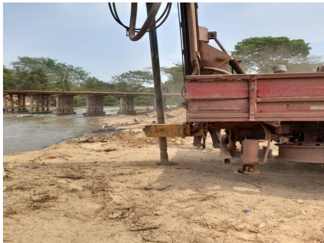
Foto 8 - Sonda rotopneumática processo perfuração
