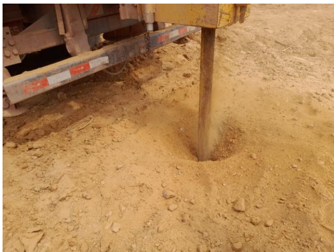
Foto 9 - Sonda rotopneumática processo perfuração
