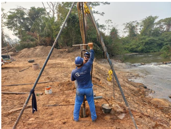
Foto 3 - Sondagem p/ lavagem (circulação d'água)
